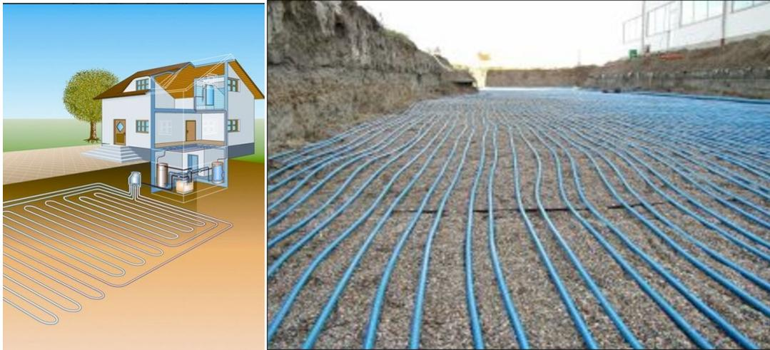
Abbildung 3.8: Prinzip Erdwärmekollektor
